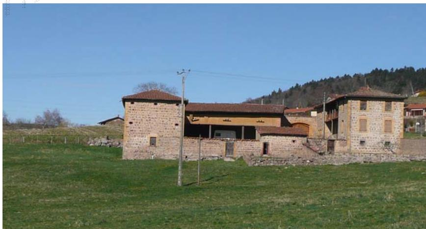
Elles sont généralement à deux pans avec des croupes aux extrémités. La pente est plutôt faible et la couverture est réalisée en tuiles canal de terre cuite.
